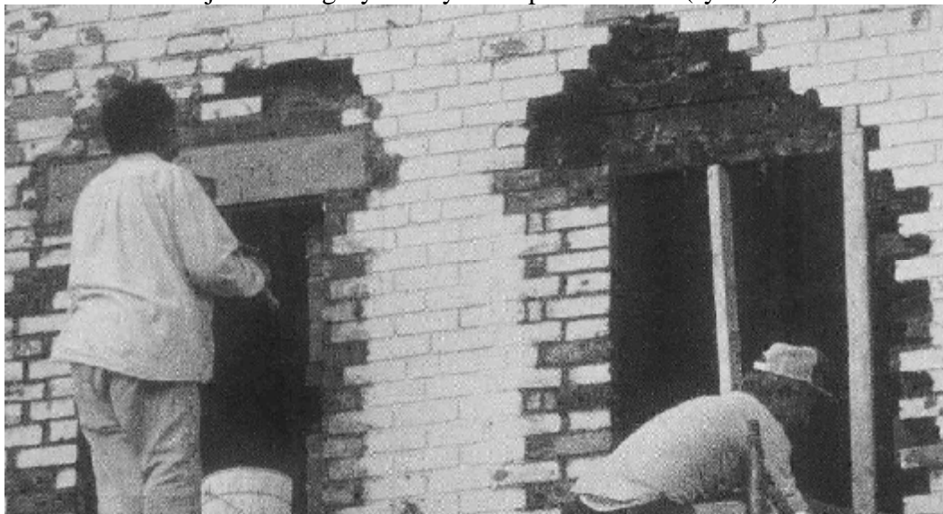
Rys.15. Przykład wymiany nadproża [5]
